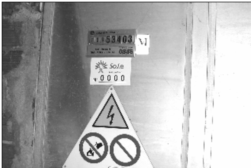
Foto 1 (porta della cabina al piano cantine).
